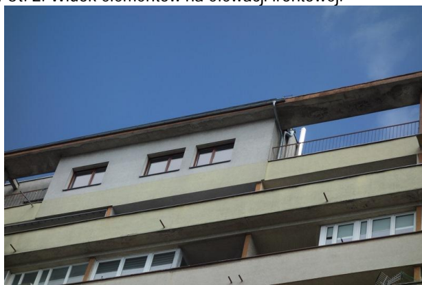
Fot. 4. Widok elementów na elewacji tylnej.
