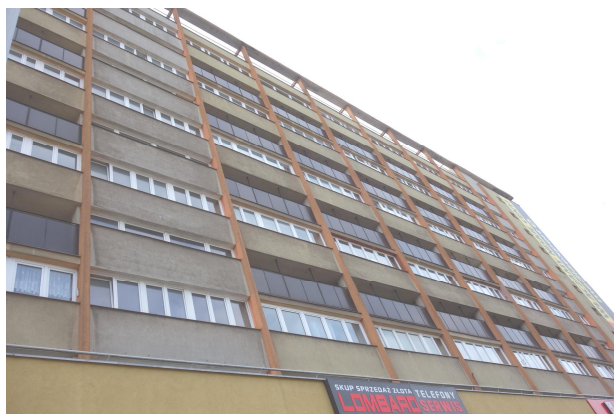
Fot. 2. Widok elementów na elewacji frontowej.
