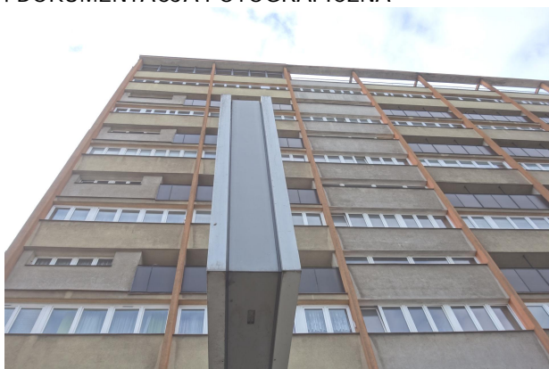
Fot. 1. Widok elementów na elewacji frontowej.
