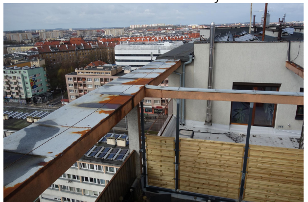
Fot. 22. Widok elementów na elewacji tylnej.
