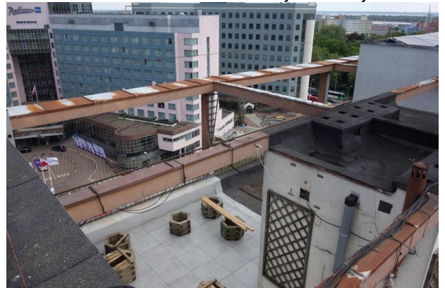
Fot. 14. Widok elementów na elewacji frontowej i w środku budynku.
