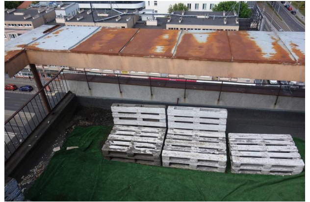
Fot. 8. Widok elementów na elewacji zach.
