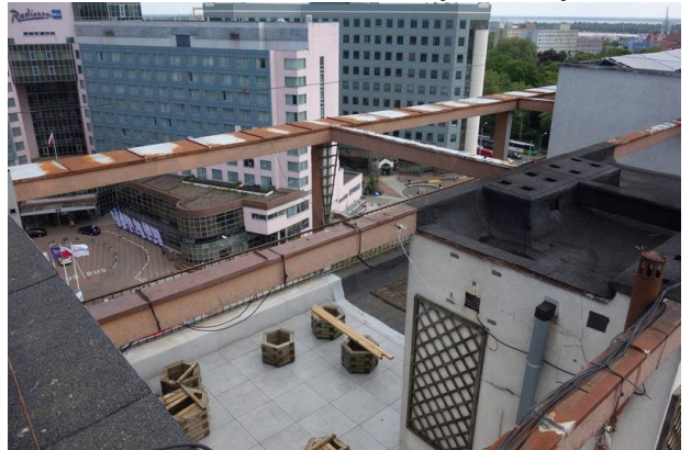
Fot. 18. Widok elementów w środku budynku.
