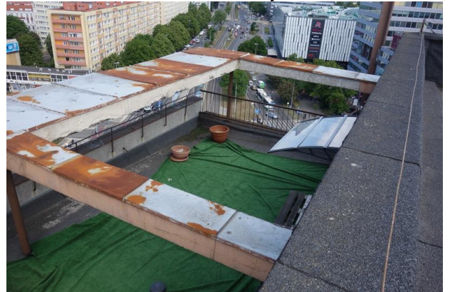
Fot. 10. Widok elementów na elewacji zach.
