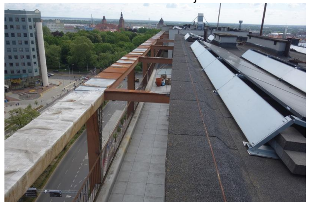
Fot. 12. Widok elementów na elewacji frontowej.
