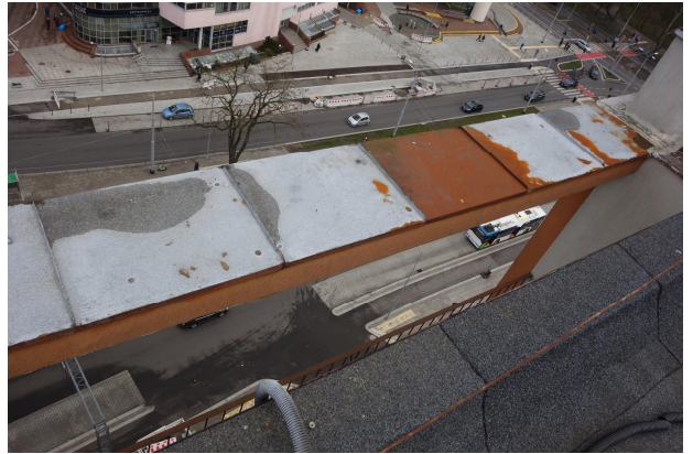
Fot. 16. Widok elementów na elewacji frontowej.
