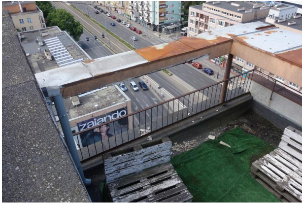
Fot. 7. Widok elementów na elewacji zach.
