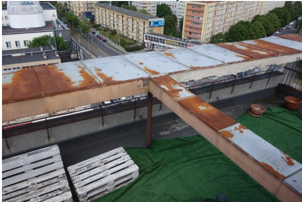
Fot. 9. Widok elementów na elewacji zach.
