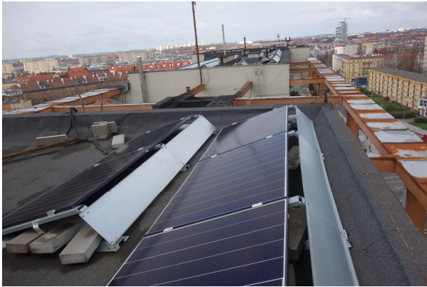
Fot. 15. Widok elementów na elewacji frontowej.
