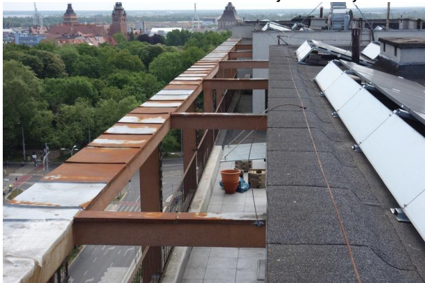
Fot. 13. Widok elementów na elewacji frontowej.
