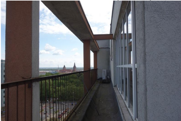
Fot. 17. Widok elementów na elewacji frontowej.
