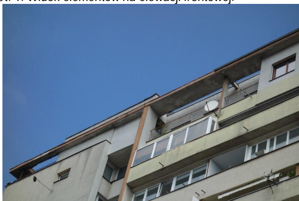
Fot. 3. Widok elementów na elewacji tylnej.
