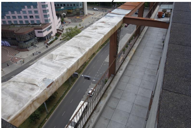
Fot. 11. Widok elementów na elewacji frontowej.
