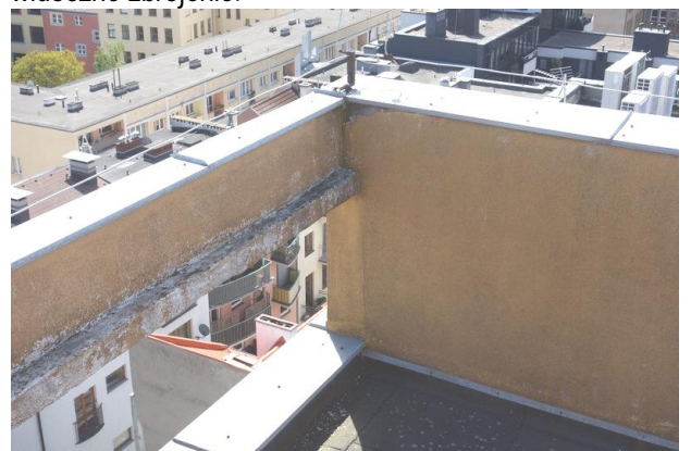
Fot. 8. Sprawdzić połączenia belka-ściana.
